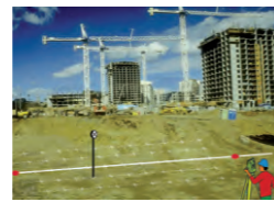
建築工地的軸線放樣和竣工檢查
