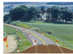
各種複雜道路線形的施工測量
